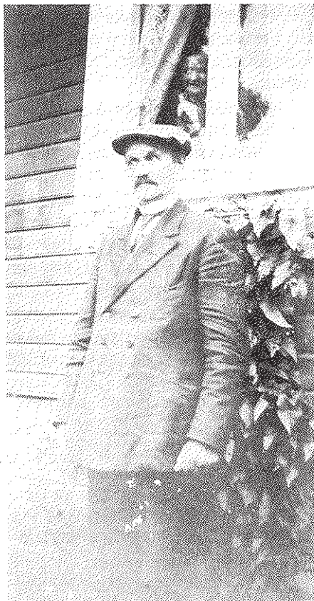
Bernt H. Gullestad (f.1864) var eier av en av gardene på Gullestad og solgte vannrettigheter. Han ble valgt inn som en av de fem medlemmene i den nye byggekomiteén. I juli 1923 mistet han livet ved en ulykke i kraftstasjonen.
