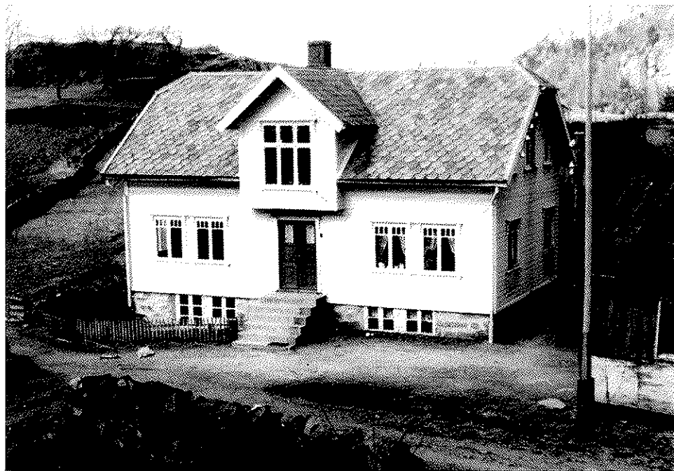
Heimehuset på Flikeid. Huset frå 1920 er bygd utanpå grunnmurane til det gamle gardshuset. Her heldt Edvin Flikeid skule i 1934-35. Stova til høgre var undervisningsrom. Stova til venstre var matsal. Foreldra til Edvin budde også i eit rom i 1. etasje. I andre etasje hadde skulestyraren to rom og «bestyrerinnen» Grethe Flikeid (seinare gift Homme) hadde to rom. Dessutan var der tre rom for lærarar og gjester. Anna Regine Bjerknes som seinare blei gift med Edvin, budde i eitt av desse romma.
