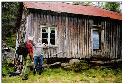
Huset sett frå framsiden. Foto utlånt fra Helga Narvestad.
